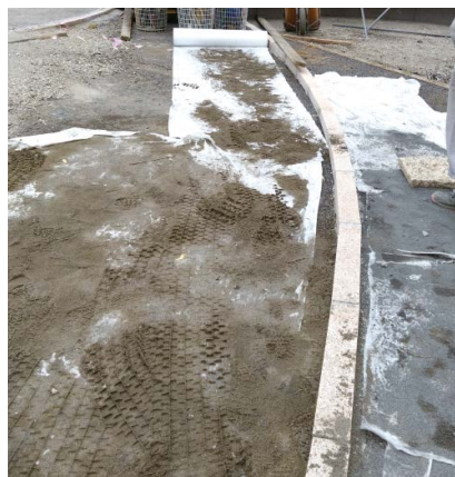
敷砂して、転圧する
