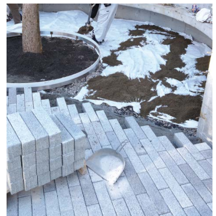
インターロッキングブロックを敷設する
