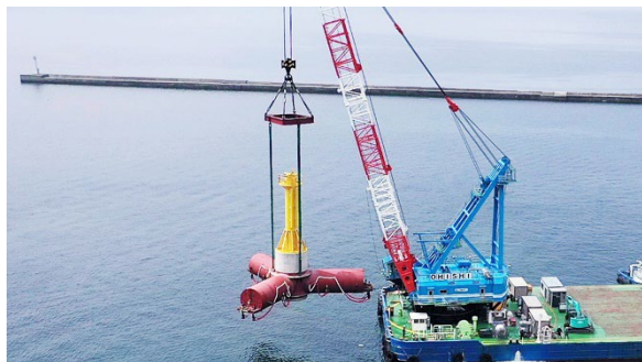
浮体の浜出し時
