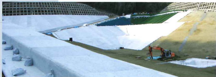
施工中の様子
