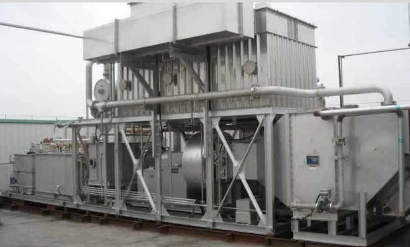
VOC処理装置 「K-FILTER ® VOC回収装置」
